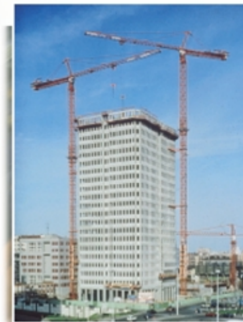
• Orientation de grues et Levage
